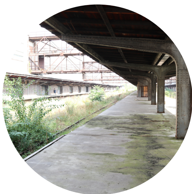
PŮVODNÍ PERONY S OCELOVOU KONSTRUKCÍ ZASTŘEŠENÍ
