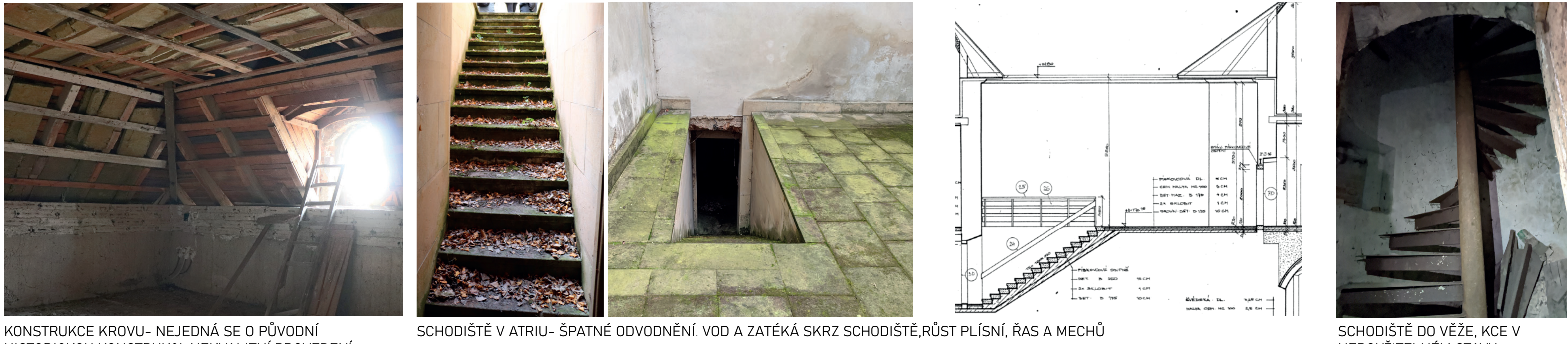
KONSTRUKCE KROVU- NEJEDNÁ SE O PŮVODNÍ HISTORICKOU KONSTRUKCI, NEKVALITNÍ PROVEDENÍ SCHODIŠTĚ V ATRIU- ŠPATNÉ ODVODNĚNÍ. VOD A ZATĚKÁ SKRZ SCHODIŠTĚ,RŮST PLISNÍ, RAS A MECHŮ SCHODIŠTĚ DO VĚŽE, KČE V NEPOUŽITELNÉM STAVU
